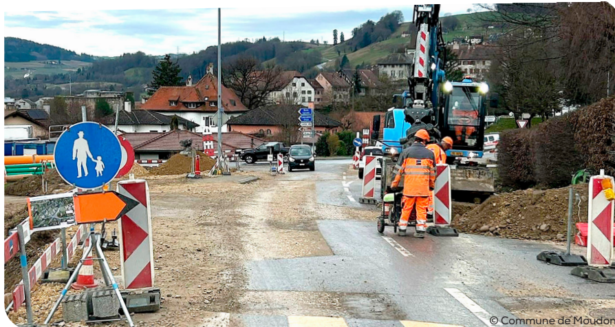
Travaux d'infrastructures de la route d'Yverdon
