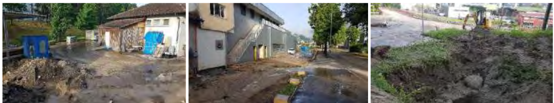
Figure 5: photos de l'inondation du ruisseau de la Brasserie du 17.06.2021
